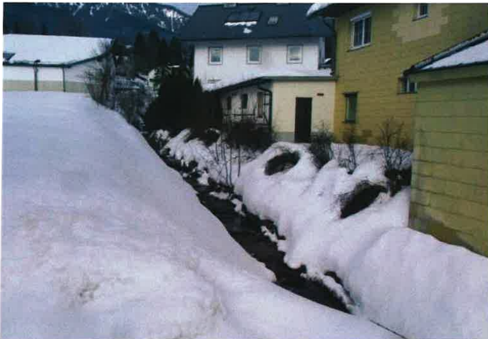
Tiefliegendes linkes Bachufer auf den ggst. Grundstücken, Blick bachaufwärts
