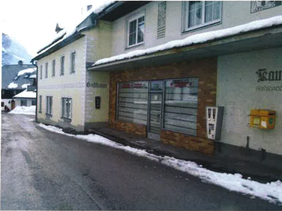
Tiefliegende Wandöffnungen beim Bestandsgebäude.
