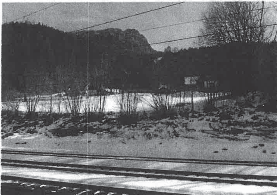
Situation Schwemmfächer Kornbauerngraben Blick Richtung Süden mit querenden ÖBB Gleisanlagen.
