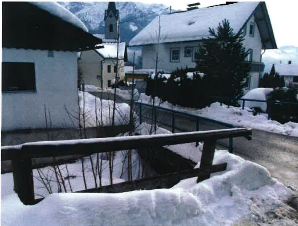
Situation: verklausungsanfälliger Brückendurchlass am Bachgerinne. Blick bachabwärts
