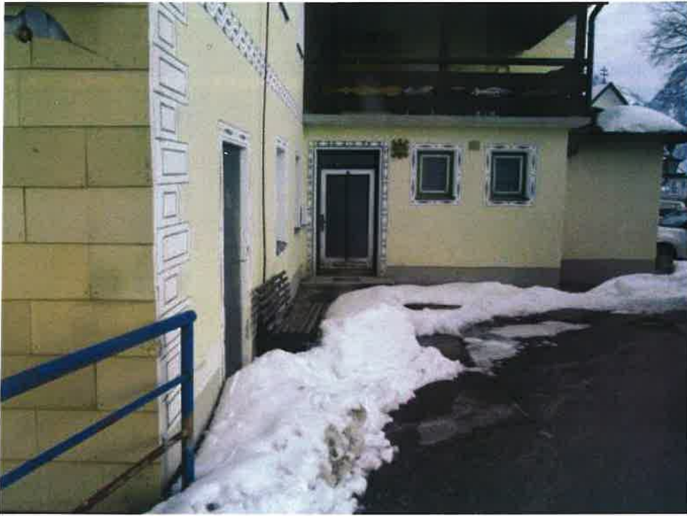
Bereich Baufläche .9 (teilweise Rote Gefahrenzone)
